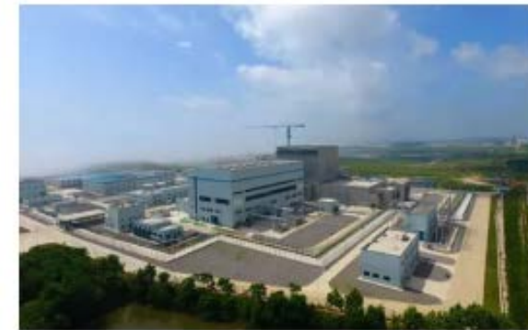
Site du démonstrateur HTR [photo: CNNC]
