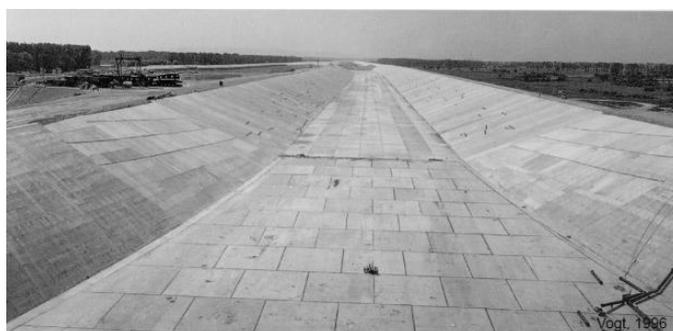
Figure 6 : Canal bétonné et dallé Source : Vogt cité par L. Schmitt
